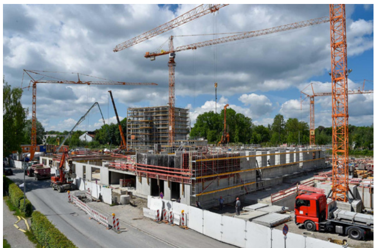
Baustelle im Mai 2020
